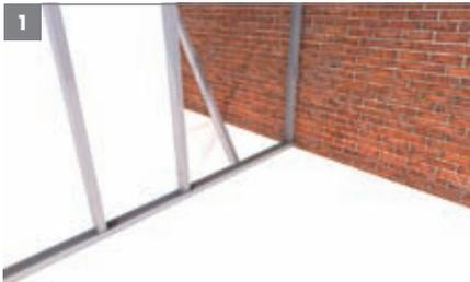
1 Fixer les profilés ou l'ossature dans l'entraxe voulu au sol, plafond et mur et utiliser, au besoin, une bande d'étanchéité.
